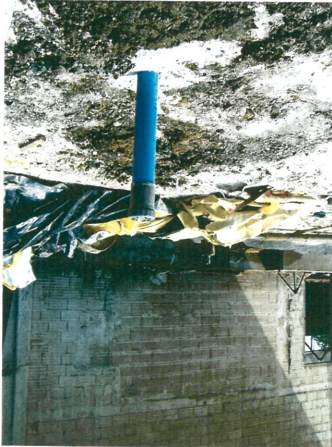
Figure n°8 : Photo d'un des piézomètres.
